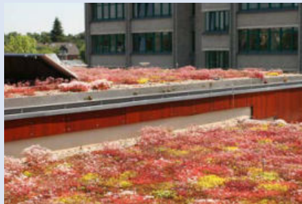
Eine Dachbegrünung mit Mauerpfeffer lässt Flachdächer aufblühen.
